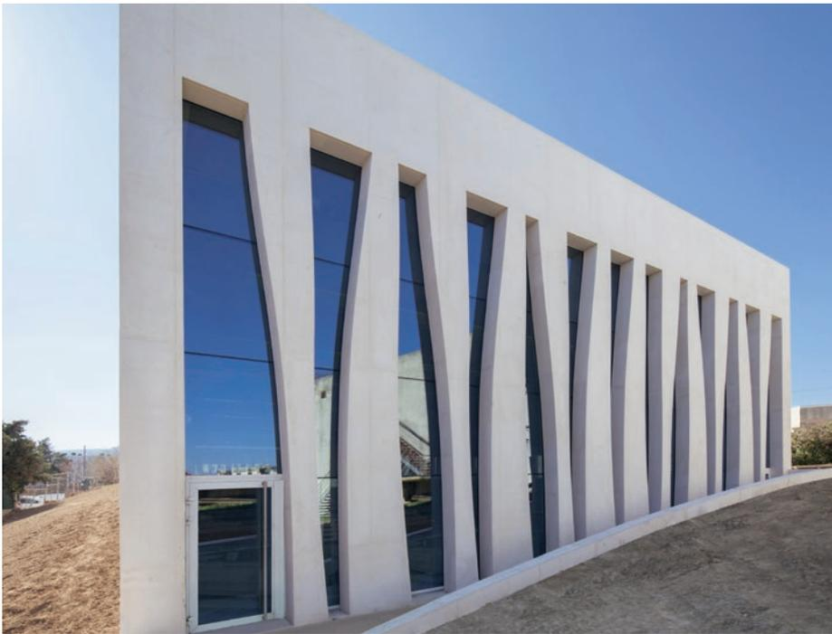
**Résultat :** cette « sculpture » monolithe de béton blanc percé fait corps avec le site. « Ancré dans la déclivité du terrain, il en reprend les courbes. Le bloc minéral est ciselé. Les hauts-reliefs verticaux sont dessinés par des lignes sorties de terre, tandis que les courbes des bas-reliefs redessinent celles du terrain naturel », explique l'architecte. Entre les lignes, les menuiseries – 111 en tout – qui épousent elles aussi le terrain.
