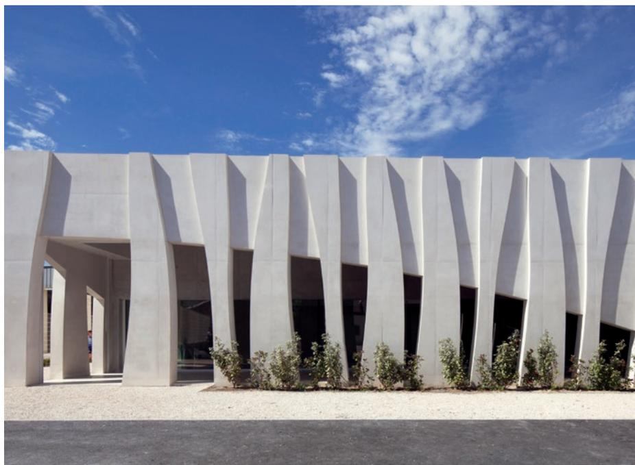
**Reproduire les mouvements tectoniques de la côte marseillaise et ceux des gymnastes avec un béton architectonique blanc immaculé. Telle était la volonté de l'architecte Fabien Geel pour la construction du nouveau gymnase du Sablier à Marseille. La réponse : un béton blanc autoplaçant de la gamme Agilia® de Lafarge.**
