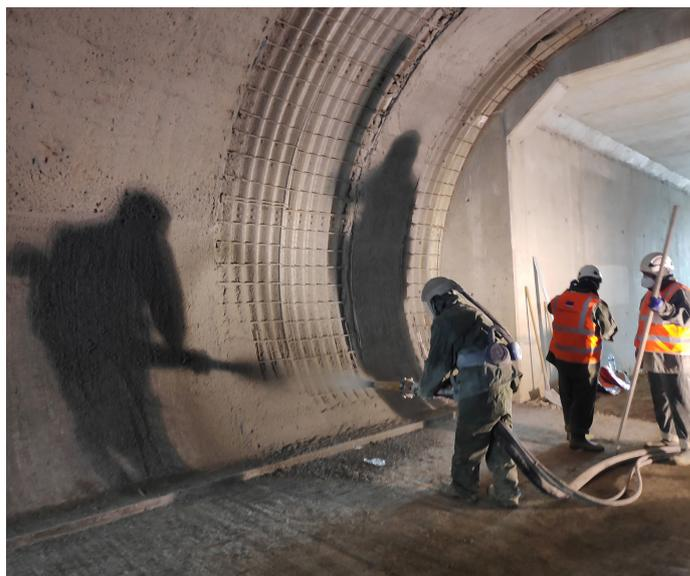
Opération de réparation et confortation d'une buse métallique grâce à Ductal®, qui a développé une solution dédiée à la rénovation de ce type de pont, permettant d'optimiser les volumes de matériaux mis en place, la durée de travaux, et préservant le diamètre initial de l'ouvrage.
