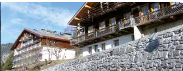
Mur de soutènement
