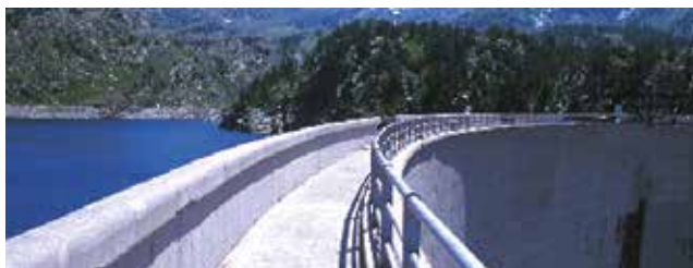
Réparation de barrages
