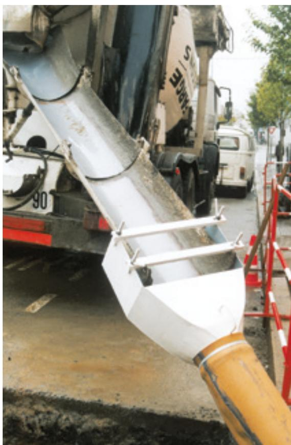
LB Coulis de remplissage est un coulis utilisé pour le remplissage des conduites usagées et le comblement des cavités.
