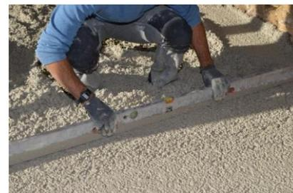
Une dalle en béton de liège a été coulée. Elle est composée de **chaux Lafarge Tradibat 85™** et de **liège fourni par l'association « La chaîne du liège »**. Celle-ci se mobilise pour récupérer les bouchons de liège afin de les valoriser en granulats de liège recyclés destinés à l'isolation des combles et des planchers. Le profit de la vente du granulat revient à deux résidences normandes pour améliorer et développer de nouvelles activités de loisirs pour les résidents handicapés.
