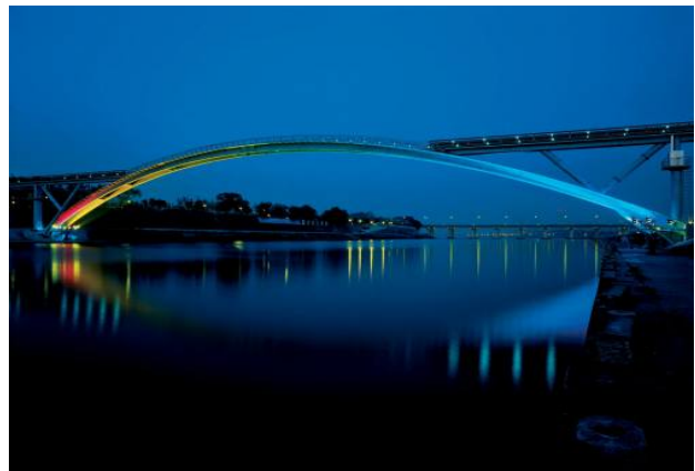
Passerelle de la Paix à Séoul en Ductal® - Rudy Ricciotti Photo Philippe Ruault
