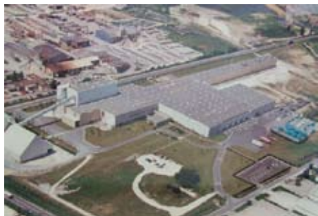
Usine de plaques de plâtre à Saint-Loubès près de Bordeaux
