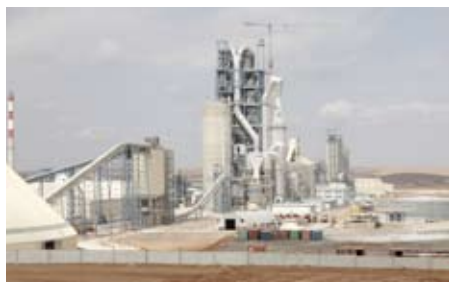
Nouvelle cimenterie d'Ein Arab, Syrie
