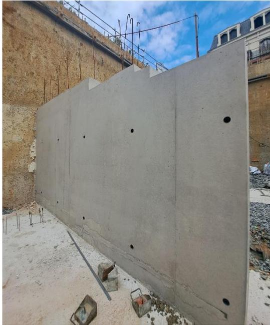
Plus qu'un simple essai, une première étape puisqu'au final ce sont 2 150 m3 de béton à base d'ECOPlanet CEM VI qui vont être coulés. Une réussite industrielle rendue possible par l'engagement des acteurs clés de ce chantier : l'entreprise **Plattard**, qui a réalisé les bétons dans son unité de Villefrance, le groupe **Tournier**, qui a assuré leur mise en œuvre dans les règles de l'art, ainsi que le promoteur **Utide**, qui a soutenu pleinement cette démarche innovante.
