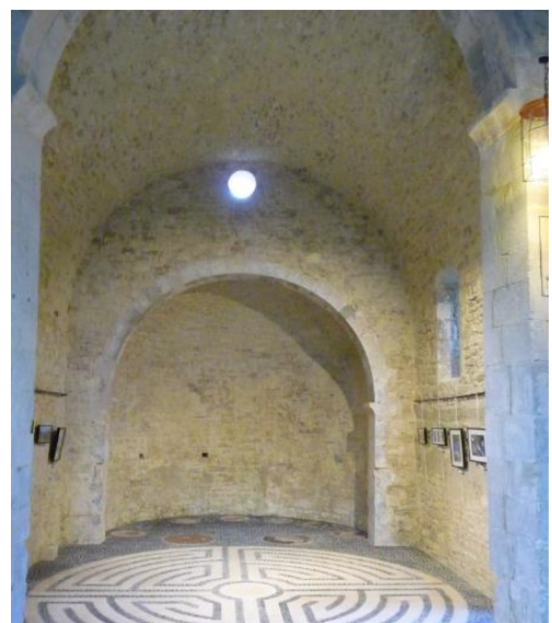
Restauration intérieure de la chapelle Saint-Jean de Crupies (26). Maître d'œuvre : l'entreprise Fabien Durif. Sol : pose de pierres avec la chaux Tradibat® 85. Murs : enduit intérieur à pierres vues avec la chaux Nathural®. Médiathèque Lafarge.
