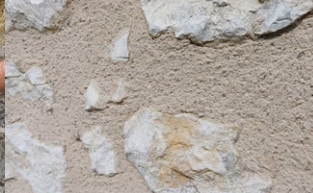
ENDUIT À PIERRES VUES
