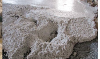
BÉTON DE CHAUX
