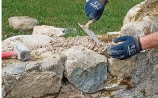
MONTAGE DE MURS
