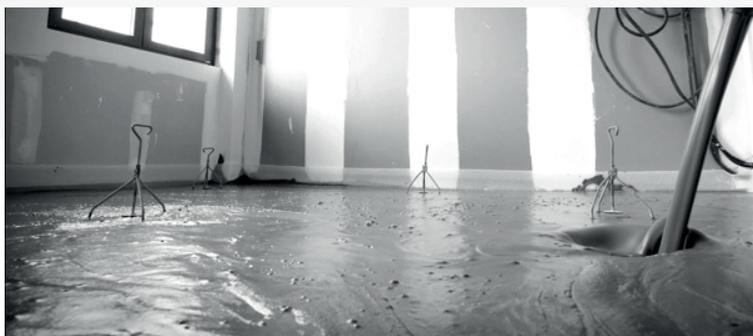
**Airium ravaillage léger et Airium ravaillage ultra léger sont des solutions de ravaillage à base de coulis de ciment et d'air.**
