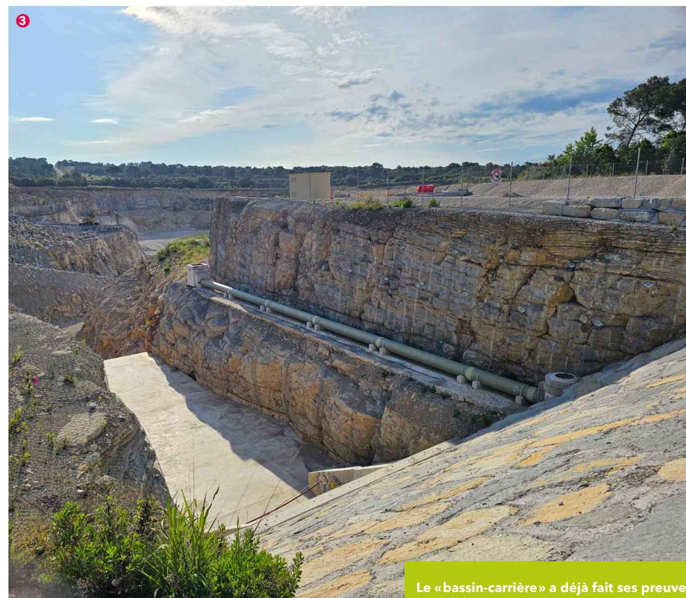
Ouvrage permettant de laisser passer l'afflux d'eau en cas de risque d'inondation vers le bassin écrêteur de crue d'Antiquailles
