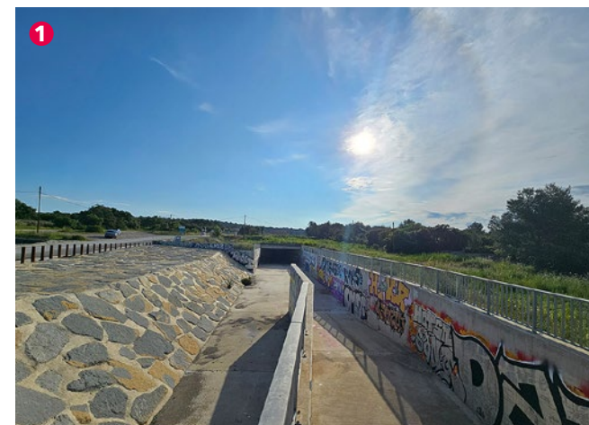
Ouvrage de collecte destiné à envoyer les eaux vers le bassin.
