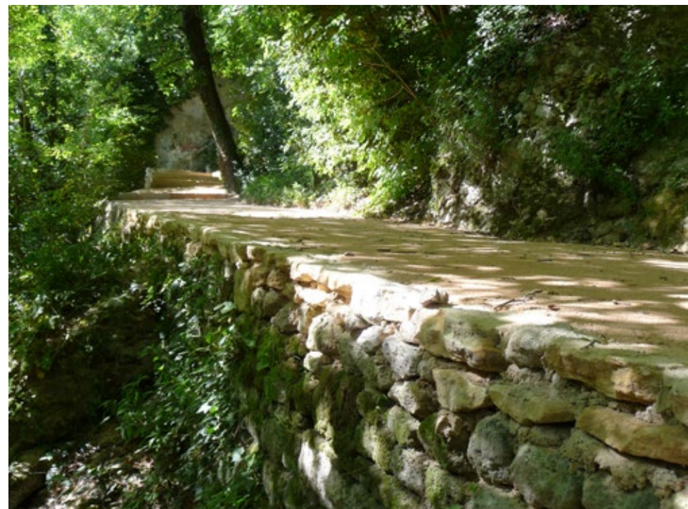
Tradifarge Plus, stabilisation des sols à Uzès (30).
