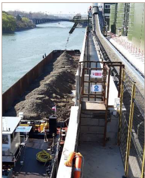
Chargement des déblais issus du tunnelier Eole
