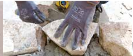
Maçonnerie de pierre
