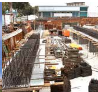
Renforcement de terrain
