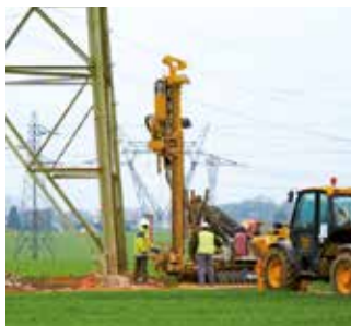
Fondations de pylônes électriques ou hertzien
