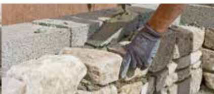
Maçonnerie de pierres
